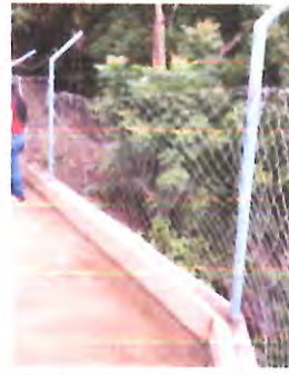
MURO O MALLA PERIMETRAL, SUSTITUCION DE MALLA PERIMETRAL
